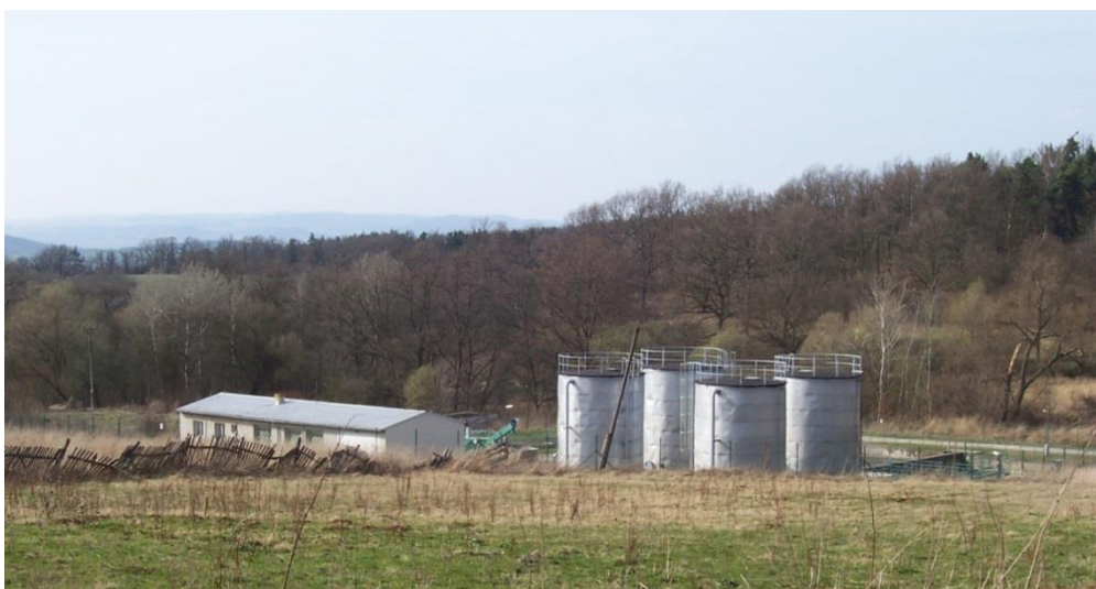
Čistírna odpadních vod (Jesenice u Rakovníka)
